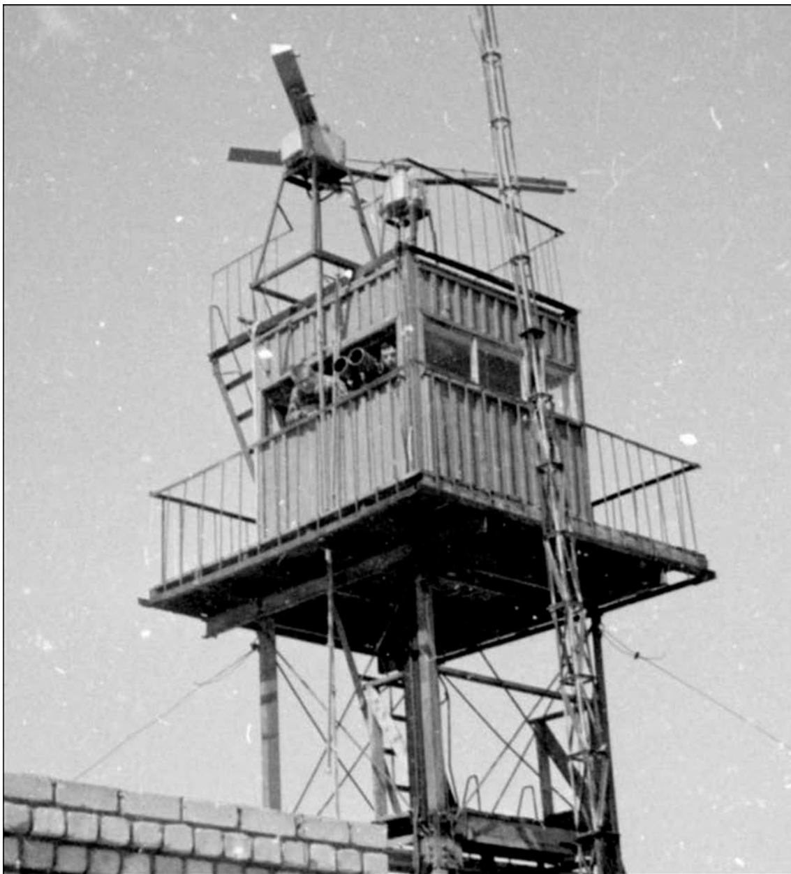
Foto 14. Haldi tehnilise vaatluse post. Vaatetorni tehniline varustus 1987. aastal: kaks radarit, merebinokkel.
