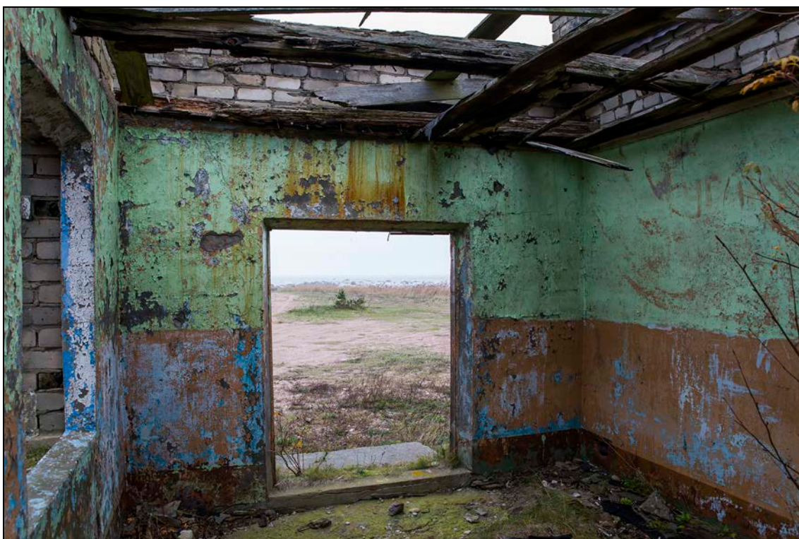
Foto 6 (062). Haldi tehnilise vaatluse post. Elektrigeneraatori ruum. Foto Mart Mõniste 26.10.2014.
