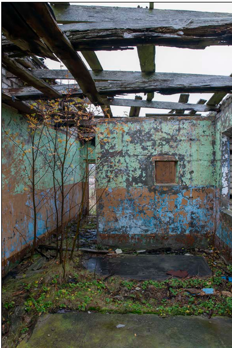
Foto 7 (060). Haldi tehnilise vaatluse post. Elektrigeneraatori ruum, põrandal näha agregaatide vundamendid. Foto Mart Mõniste 26.10.2014.
