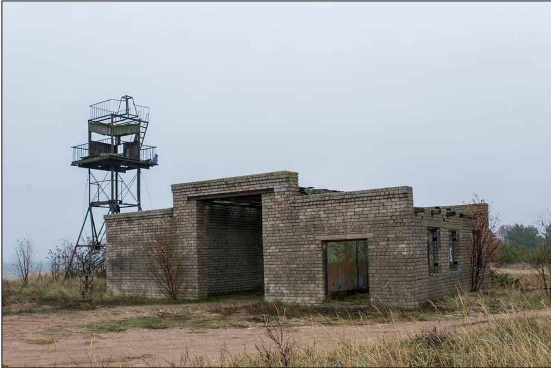
Foto 3 (049). Haldi tehnilise vaatluse post. Hoone parempoolses tiivas on diisलगeneraatori ruum, vasakul meeskonnaruum, keskel prožektoriangaar. Foto Mart Mõniste 26.10.2014.
