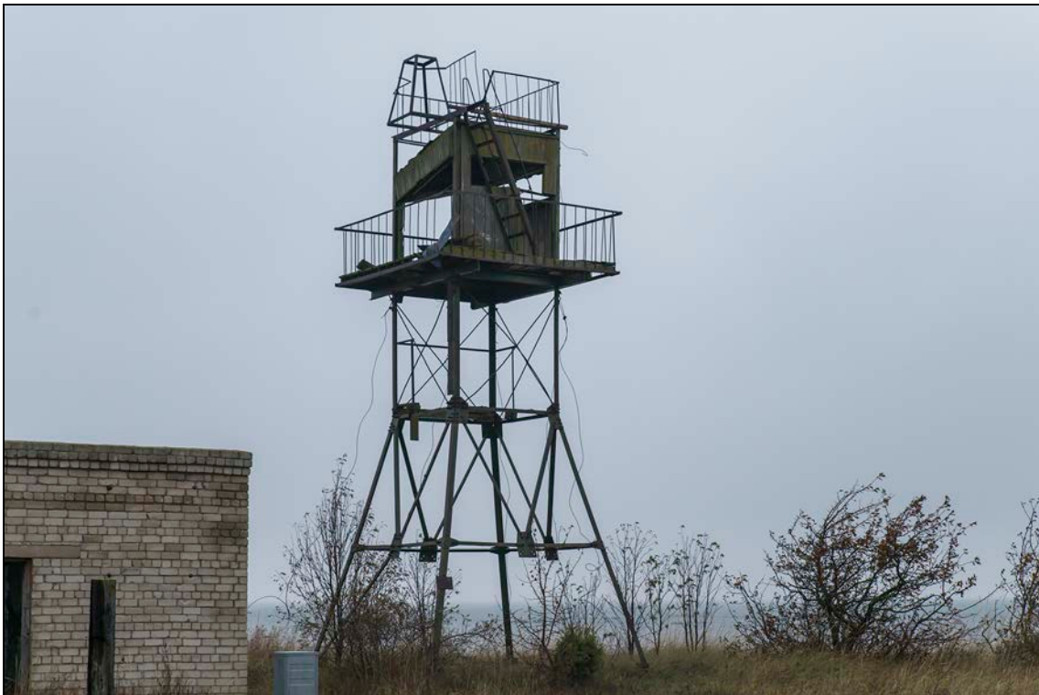
Foto 10 (045). Haldi tehnilise vaatluse post. Vaadetorni trepid on kadunud, aga ülemised konstruktsioonid, piirded ja radari alus veel alles. Foto Mart Mõniste 26.10.2014.
