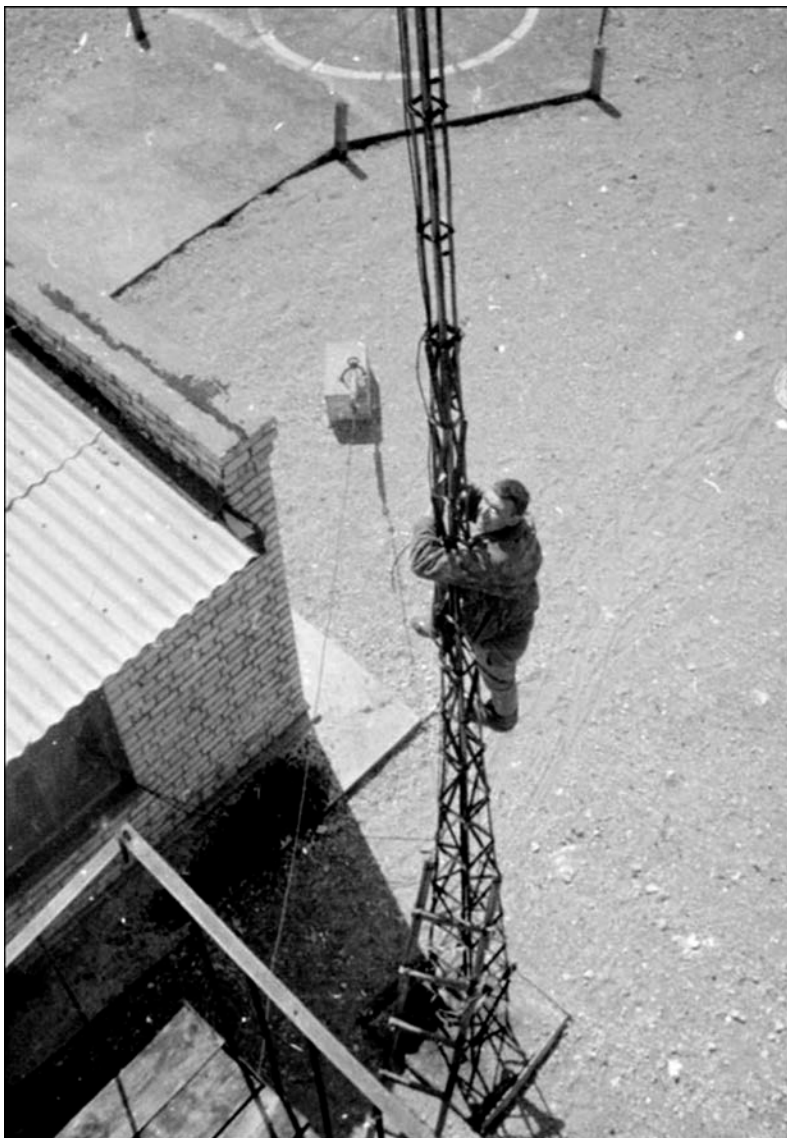
Foto 14. Haldi tehnilise vaatluse post. 1987.
