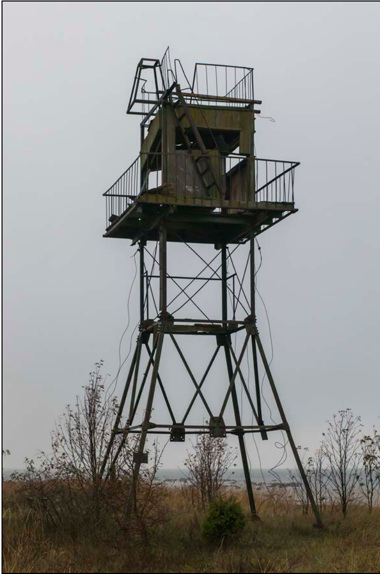
Foto 14 (083). Haldi tehnilise vaatluse post. Vaatetorn on ilmselt Hiiumaa madalaim. Praeguseks hävinud Hirmuste ja Tahkuna tornid olid ühe sektsiooni (2,5 m) võrra kõrgemad. Foto Mart Mõniste 26.10.2014.
