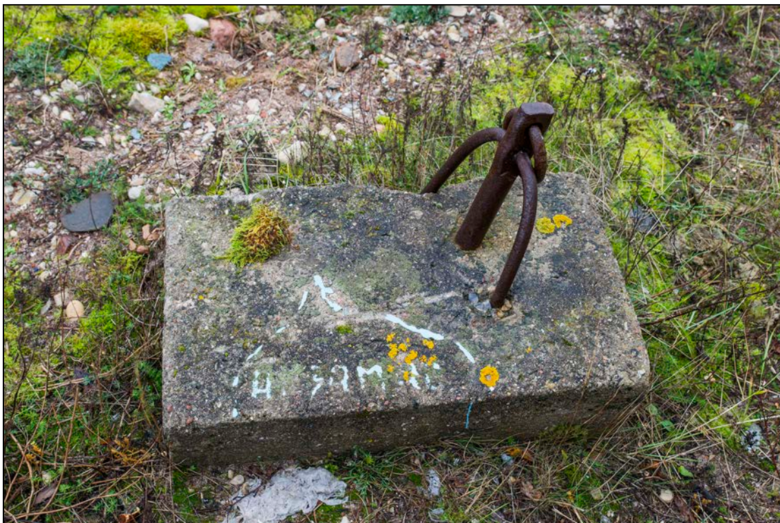
Foto 13 (059). Haldi tehnilise vaatluse post. Raadiomasti vantide vundament. Foto Mart Mõniste 26.10.2014.
